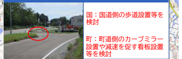
新地町小川字坂越(国道6号・町道並行箇所)
